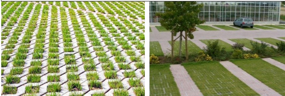
Exemples de stationnement perméable :
